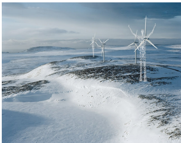
Рис. 3. Пример существующего решения совмещенной дизайнерской опоры и мачты для ветряков (Аргентинская компания DOMA, 2012 г.)
