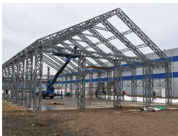
Рис. 5. Каркас промышленного здания
